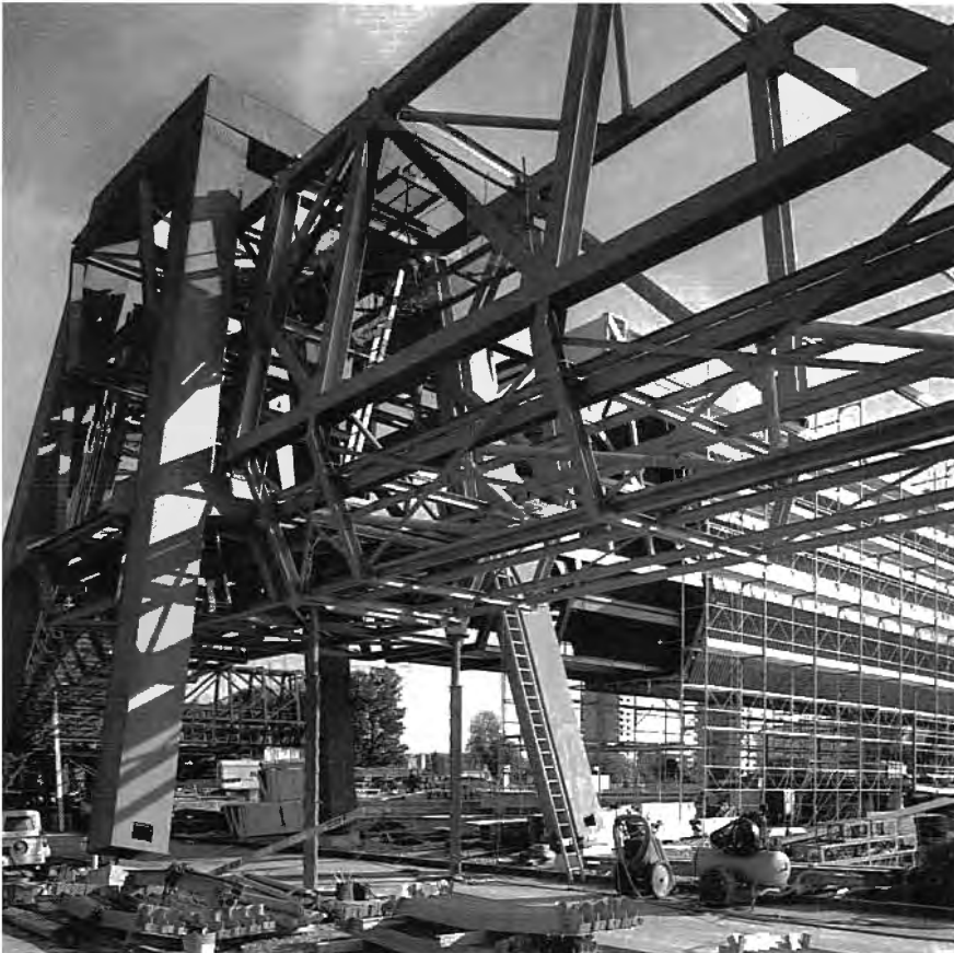
Stahlbau in der Kläranlage Werd- hölzli, Zürich. Montage Geilinger AG, Winterthur.
