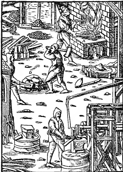
Der Herd A. Der Befschickungshaufen B. Der Schlackmaßfuß C. Der Eisanklumpen (Maßfuß) D. Die Holzkammer E. Der große eiserne Hammer F. Der Amboss G.
