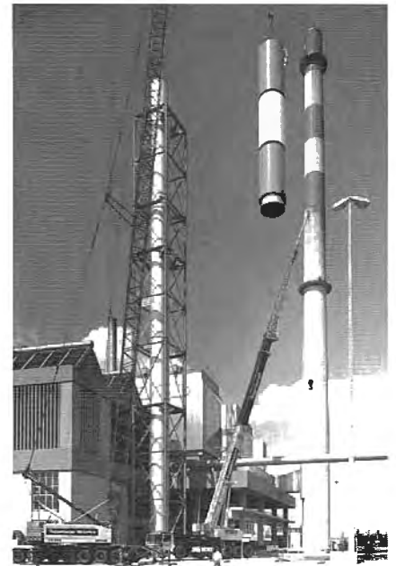
Stahlkaminbau in der KVA-Hagenholz (ZH) (Geilinger Winterthur)
