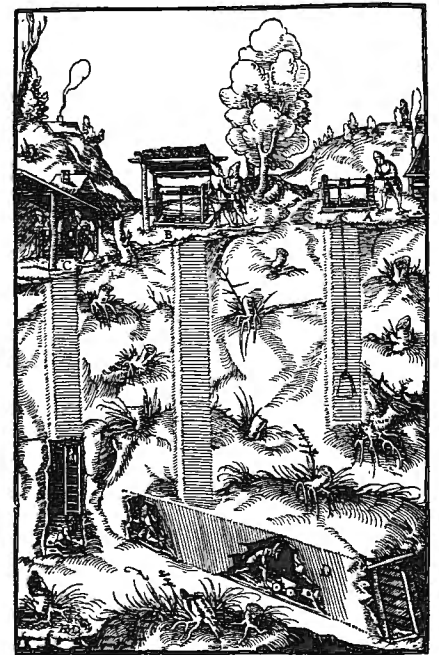
Drei jüngere Schächte. Der erste Schacht, der noch nicht bis zum Stollen gestuft ist A. Der zweite Schacht, der den Stollen erreicht hat B. Der dritte Schacht, bis zu dem der Stollen noch nicht vorgedrungen ist C. Der Stollen D.
