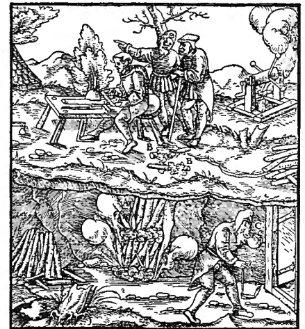
Feuersetzen (aus Agricola)
